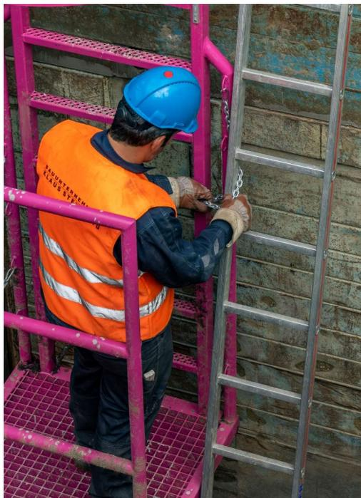
01 Die Leiter wird an der Anlegeseite mittels einer Kette so stramm wie möglich um den Leiterholm fixiert um ein seitliches Kippen zu verhindern.
