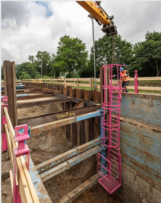
01 Einhängen mittels Bagger.
