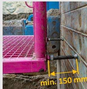
04 Am unteren Podest und an möglichst jedem zweiten Zwischenstück der Verbauleiter befinden sich 2 Einstellschrauben (SW30) zur lotrechten Ausrichtung. Der Mindestabstand zum Verbau muss 150mm betragen um für ausreichende Trittsicherheit zu sorgen.
