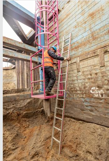
02 Je nach „Anlegeseite“ der Leiter am unteren Podest wird eine Kette rechts bzw. links über Karabiner gelöst.
